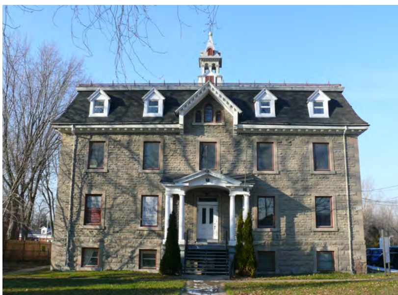
Ancien couvent des Sœurs de Sainte-Croix, construit en 1875-1876. 233, boulevard Sainte-Rose. Photo : Patri-Arch, 2015.
