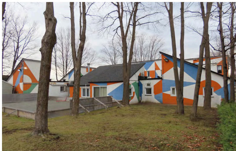
Façades extérieures de l'ancienne entreprise Vermont Construction (Vincent, 1969-1970), une œuvre d'Alfred Pellan. 845, rue Lippmann.
