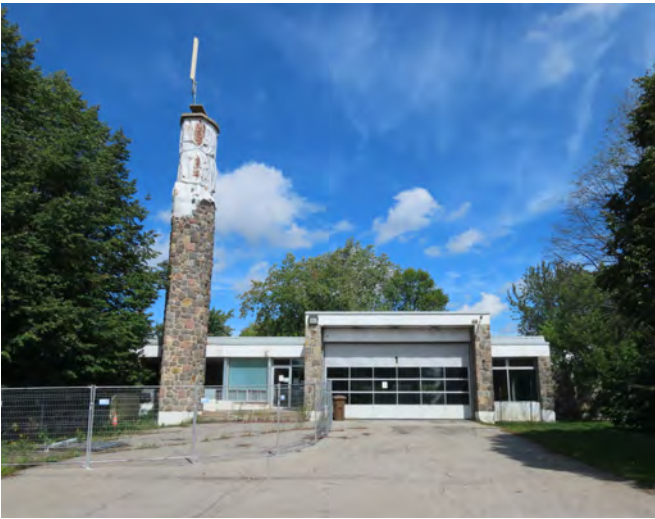
Caserne n° 5 et station de chloration, datant de 1962-1963. André Ritchot, architecte. 6645, rue Duranleau.
