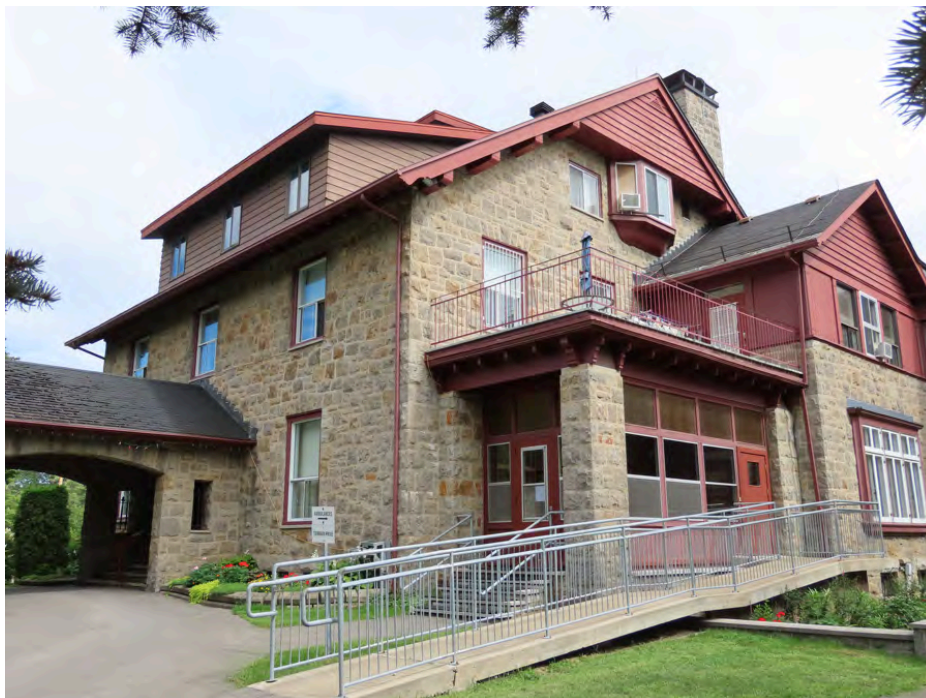
Maison mère des Sœurs missionnaires du Christ-Roi, érigée en 1940. 4730, boulevard Lévesque Ouest.
