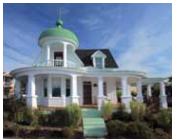
4495, boulevard Lévesque Ouest
