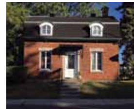
3257, boulevard Lévesque Ouest
