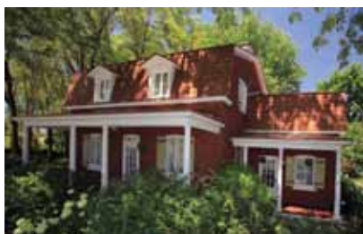
4997, boulevard Lévesque Ouest
