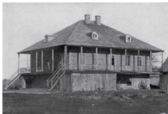
Manoir Vinet, cap Saint-Martin (1487, boulevard des Laurentides)
