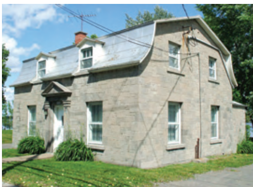
5682, boulevard Lévesque Est : une des rares résidences épargnées lors de la démolition du bas du village. * ➔ Photographie : Vicki Onufriu, 2008.
