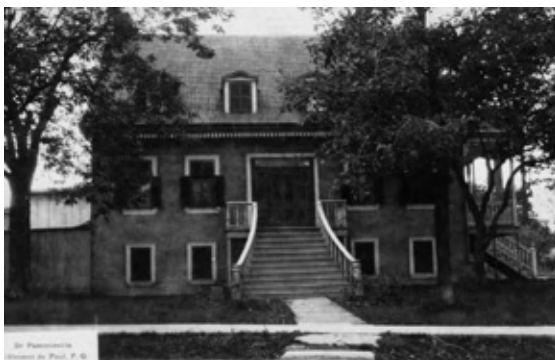
L'apparence d'origine de la maison d'Amélia Merckell, avec ses lucarnes et son escalier aujourd'hui disparus. Point d'intérêt n° 27. Collection privée Vicki Onufriu.
