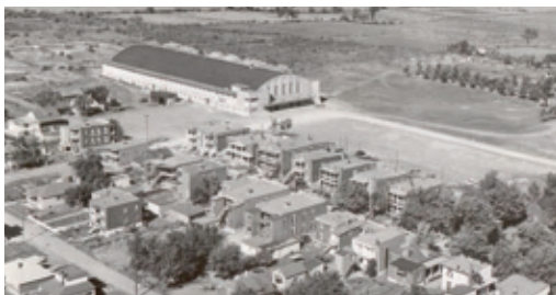
Vue aérienne du secteur de la rue de la Fabrique, vers 1954.
