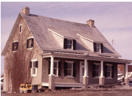
Vue frontale de la maison avant son déplacement.
