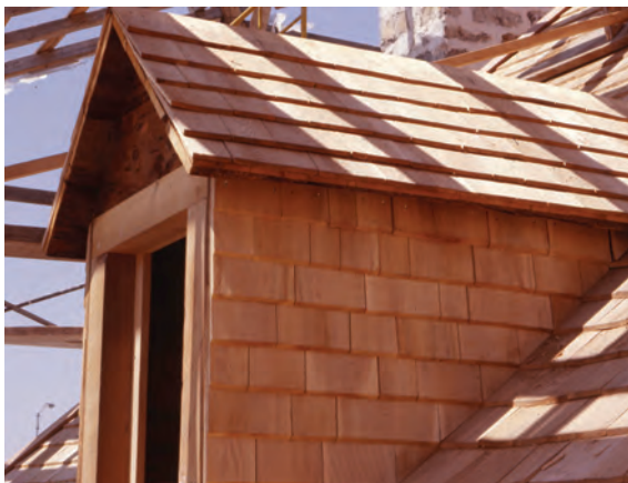
Restauration des lucarnes et recouvrement de bardeaux de cèdre, 1975-1976. Archives de la Ville de Laval, fonds de la Maison André-Benjamin-Papineau.
