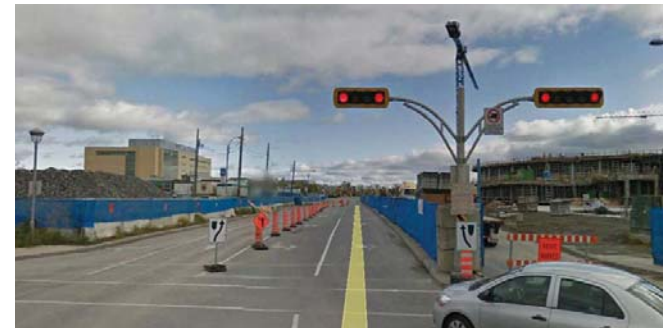
LE SITE EN CHANTIER - Google
