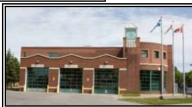
Caserne 3 - Concorde 4111, boulevard Concorde
