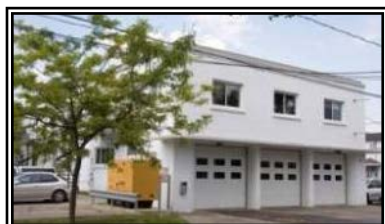
Caserne 6 – Laval-Ouest 2392, 35 e Avenue
