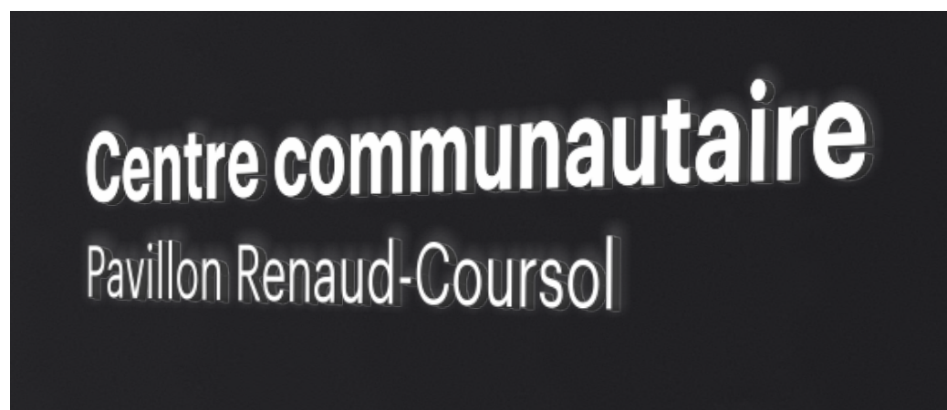
Éclairage de la face du lettrage blanc sur surface foncée
