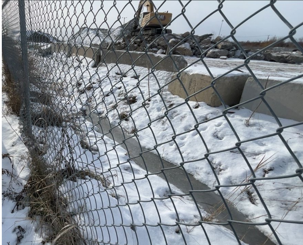
Fossé de drainage municipal
