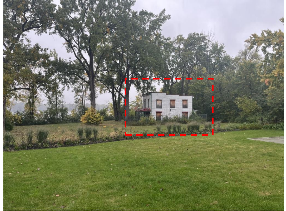
Vue de l'atelier à partir de la résidence
