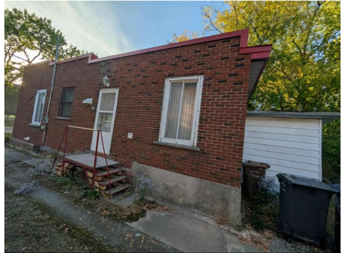
Façade gauche Source: Requérant
