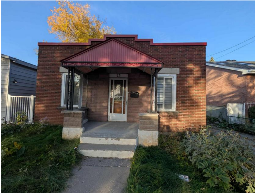
Façade avant Source: Requérant
