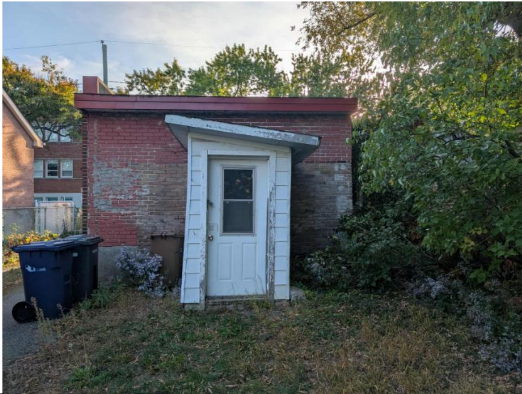
Façade arrière Source: Requérant
