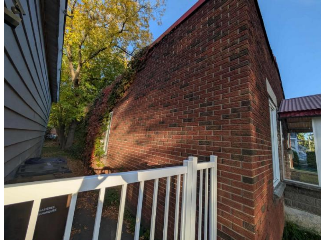
Façade droite Source: Requérant
