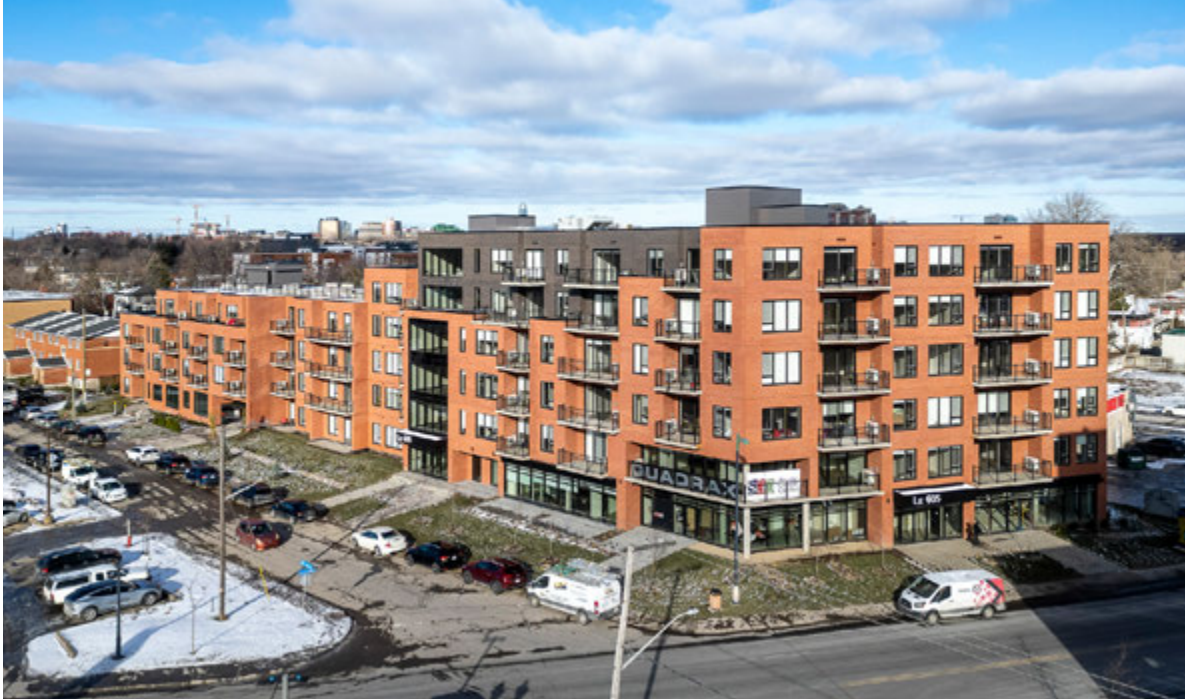
Projet de logements sociaux et abordables Le Racine, 2025. | Crédit photo : Louis-Étienne Doré.
