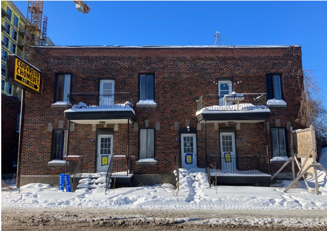
Façade avant Source: Requérante
