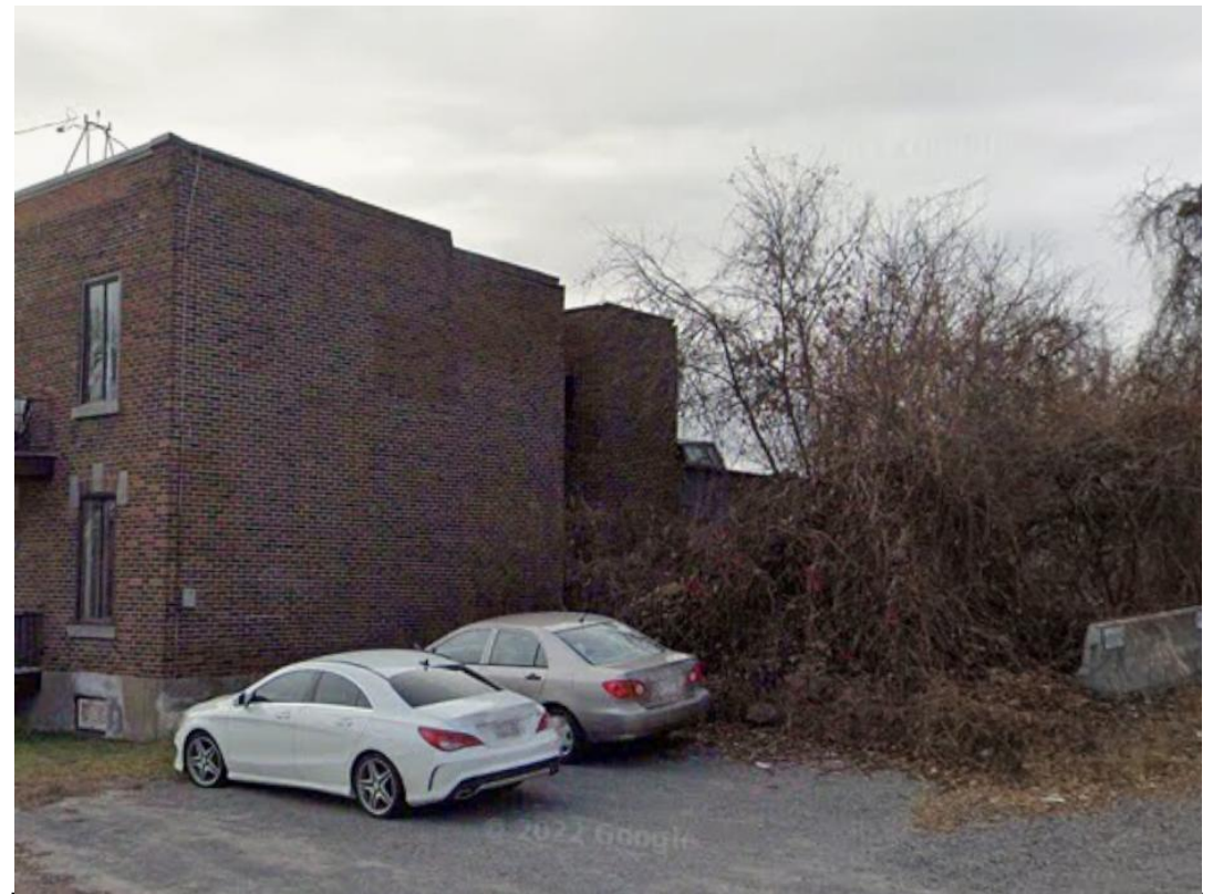
Façade droite Source: juin 2020 © 2024 Google
