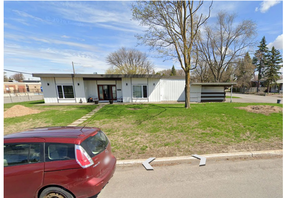
Bâtiment voisin de droite (3141, rue Esther)
