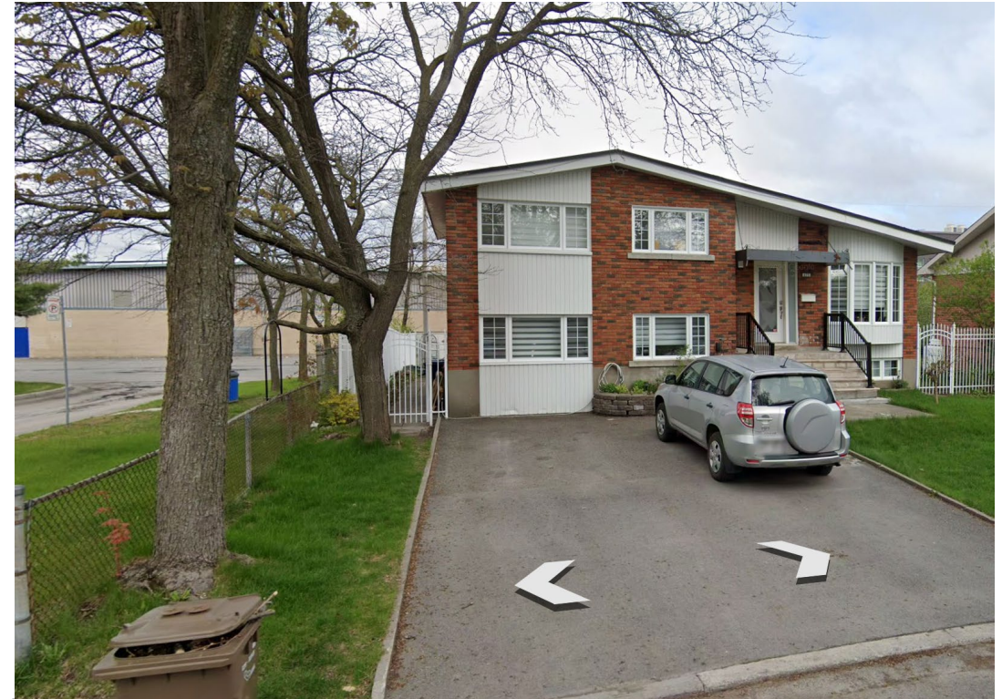
Bâtiment voisin (475, rue Élyse)
