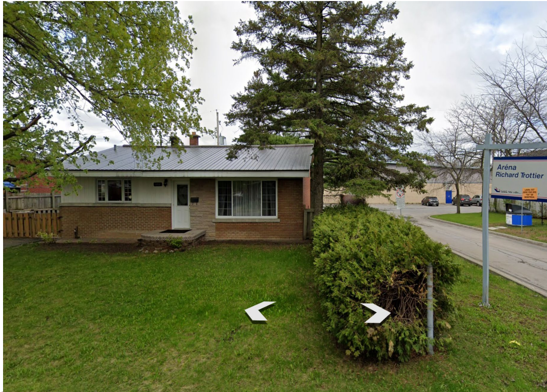
Bâtiment voisin (459, rue Élyse)
