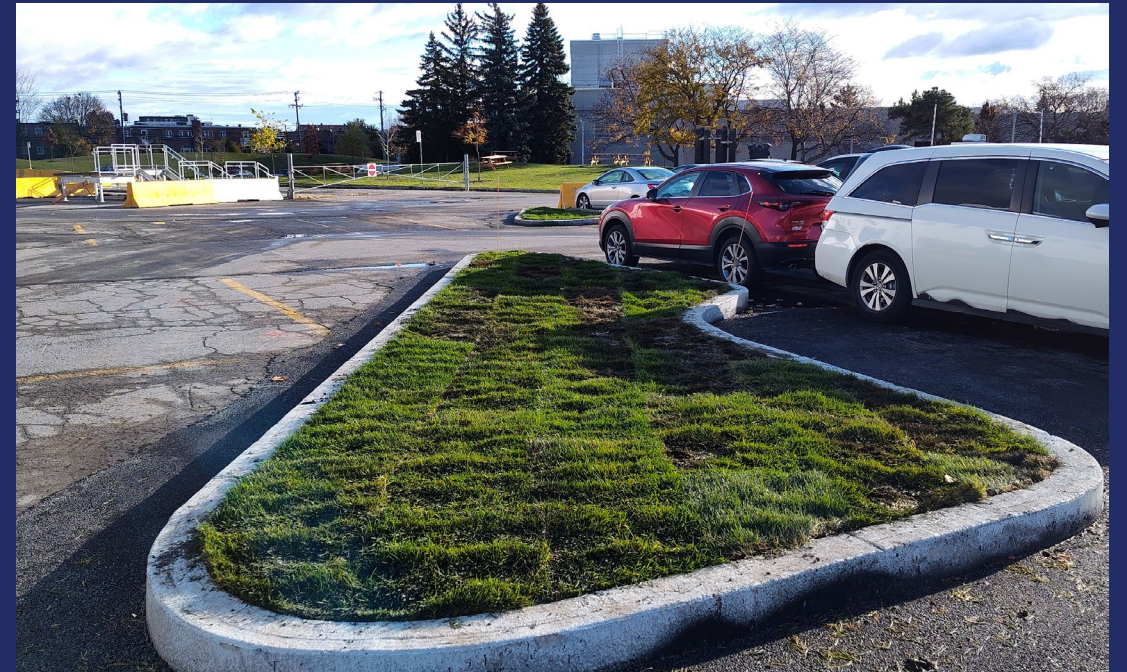
Réaménagement de l'aire de stationnement Source : Ville de Laval, novembre 2025
