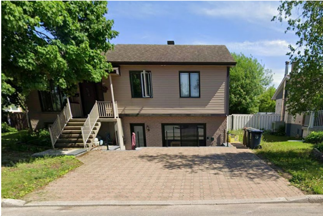
Bâtiment voisin arrière (108, rue Aimé-Séguin)
