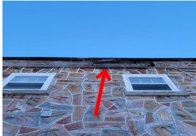
Pourriture et infiltration
