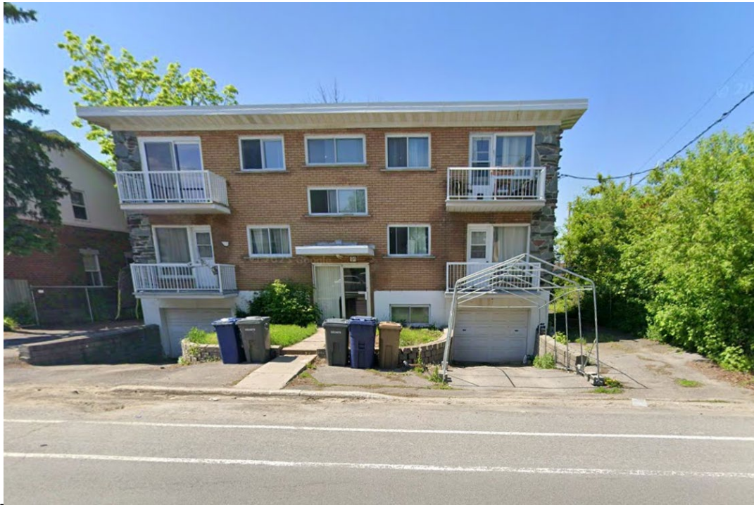
Bâtiment voisin de gauche (91, boul. Saint-Elzéar Est) Source: mai 2025 © 2025 Google
