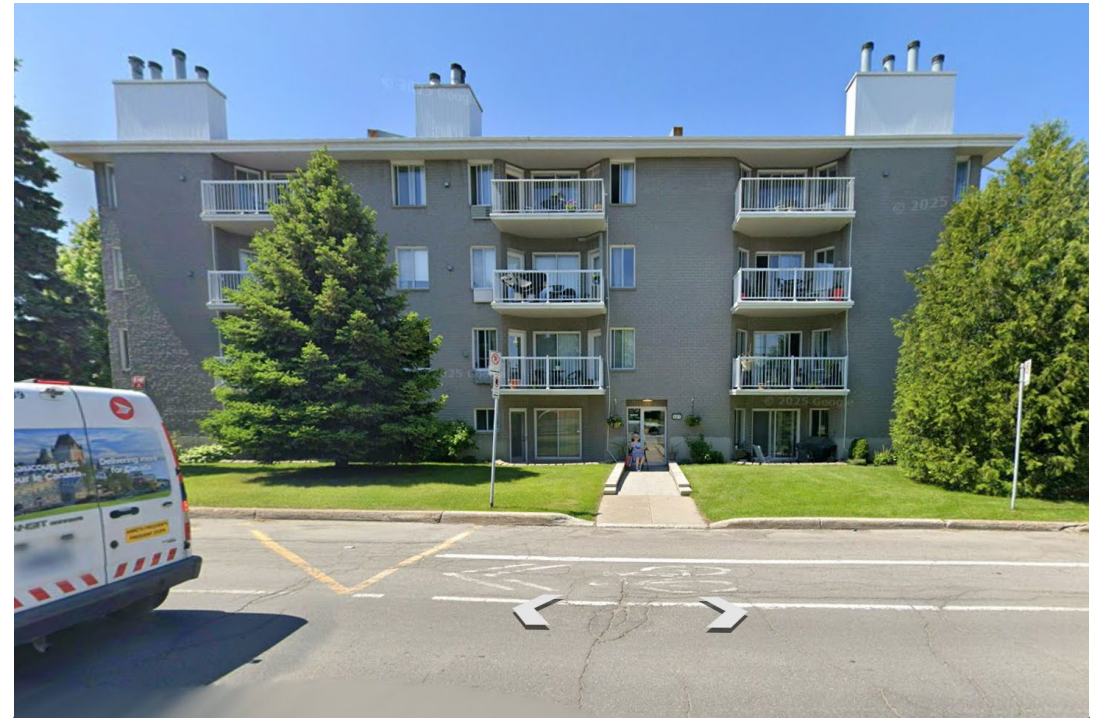
Bâtiment voisin de droite (127, boul. Saint-Elzéar Est) Source: mai 2025 © 2025 Google
