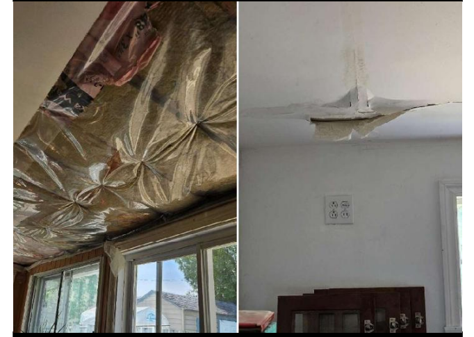
Infiltration d'eau
