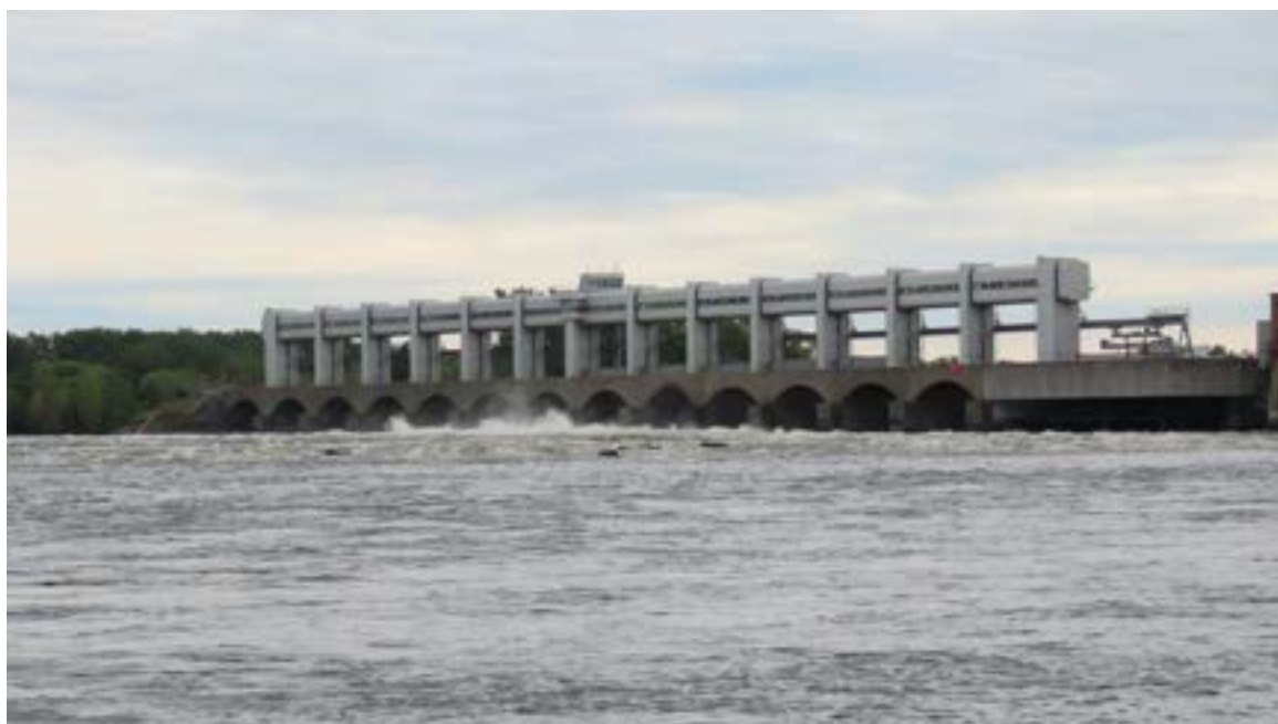
Évacuateur de crues (section sud) du barrage de la Rivière-des-Prairies, construit en 1984, sur la rivière du même nom. Il comprend une succession d'arches de béton au-dessus desquelles se trouvent les portiques d'acier contenant les équipements de levage des portes de l'évacuateur de crues.
