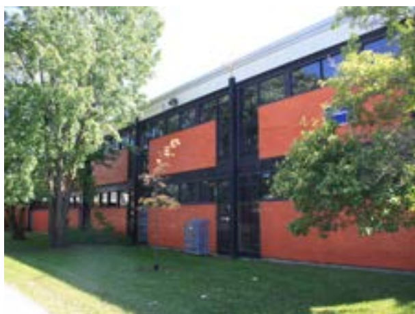
École primaire Léon-Guilbault (édifice 1), 133, boulevard Cartier Ouest (Laval-des-Rapides), 1966.
