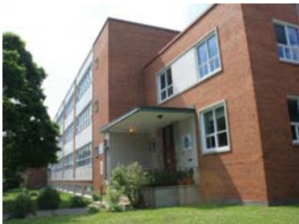
École primaire Saint-Gilles (édifice 2), 226, rue des Alpes (Pont-Viau), 1960.
