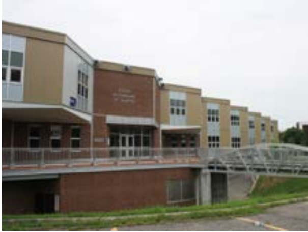
École secondaire Saint-Martin, 4055, boulevard Saint-Martin Ouest (Chomedey), Des Rochers et Dumont, architectes, 1961.
