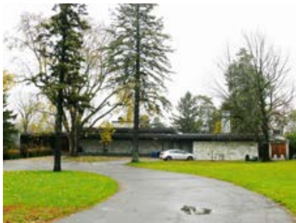
Maison Jean-Simard, 159, rue Les Érables (Laval-sur-le-Lac), Roger D'Astous, architecte, 1962–1963.
