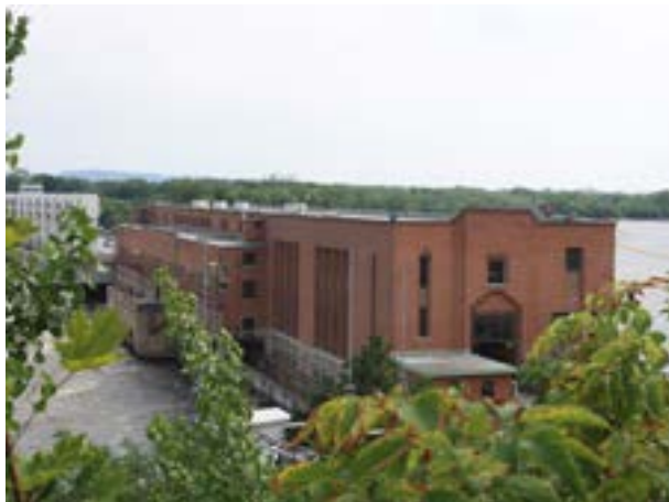
La centrale hydroélectrique de la Rivière des Prairies, 3400, rue du Barrage (1929).
