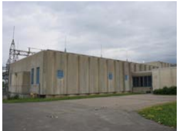
Poste Landry d'Hydro-Québec, 3255, boulevard Saint-Martin Est (Duvernay), 1969.
