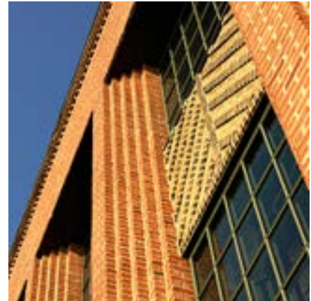
Détails de la façade en brique de la centrale hydroélectrique de la Rivière des Prairies, 3400, rue du Barrage.
