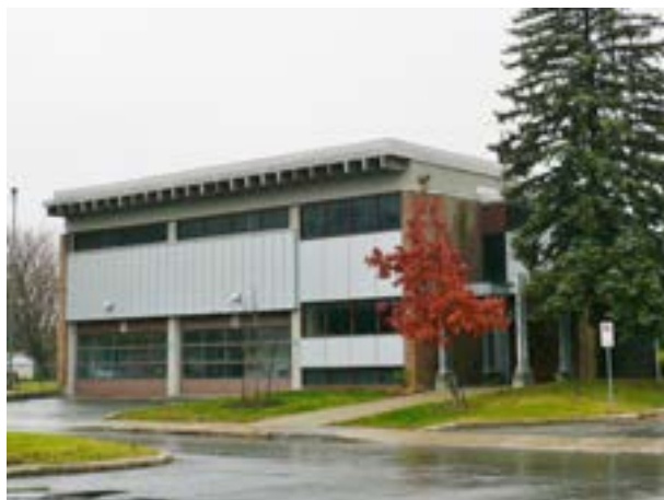
Ancien hôtel de ville de Sainte-Dorothée, 950, boulevard de l'Hôtel-de-Ville (Sainte-Dorothée), Jacques Vincent, architecte, 1961-1962.
