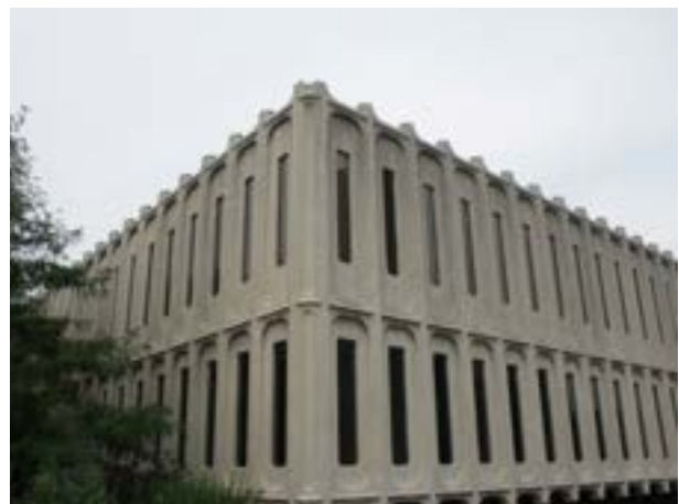
Édifice Berthelo, 3333, boulevard du Souvenir (Chomedey), Guillaume Gagnon, architecte, 1970.
