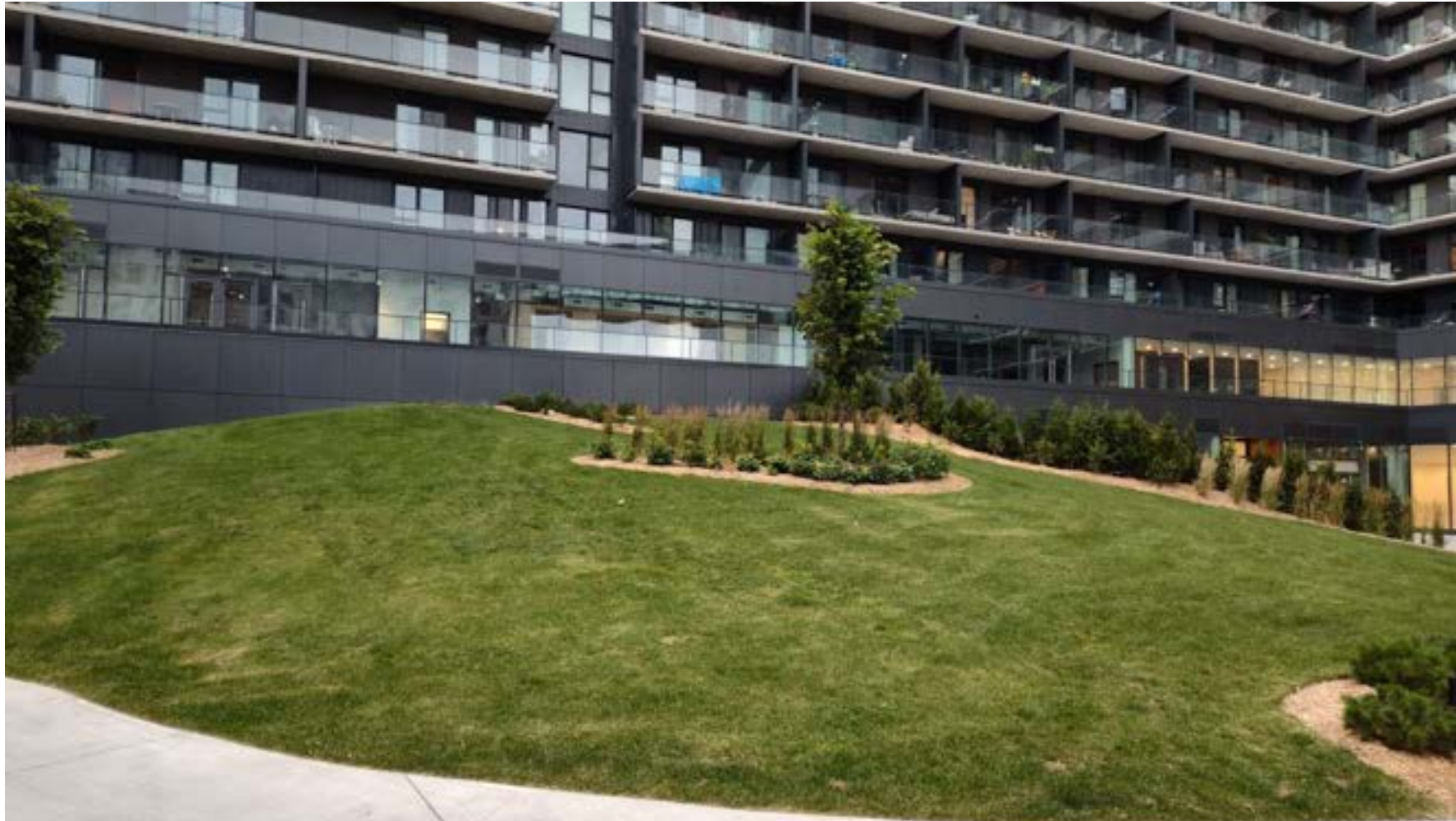
Vue sur le site (tour 1 – façade est) – Photo prise en date du 20 juillet 2024
