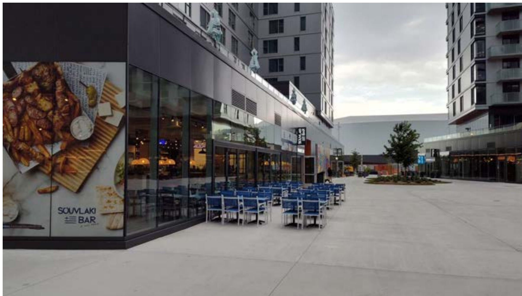
Vue sur le site (tour 3 – façade ouest) – Photo prise en date du 20 juillet 2024
