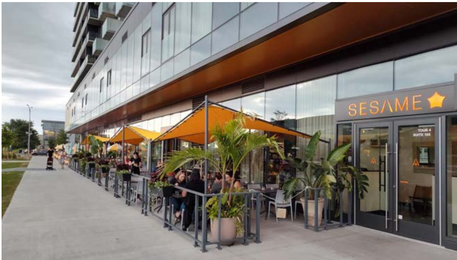
Vue sur le site (tour 4 – façade sud) – Photo prise en date du 20 juillet 2024
