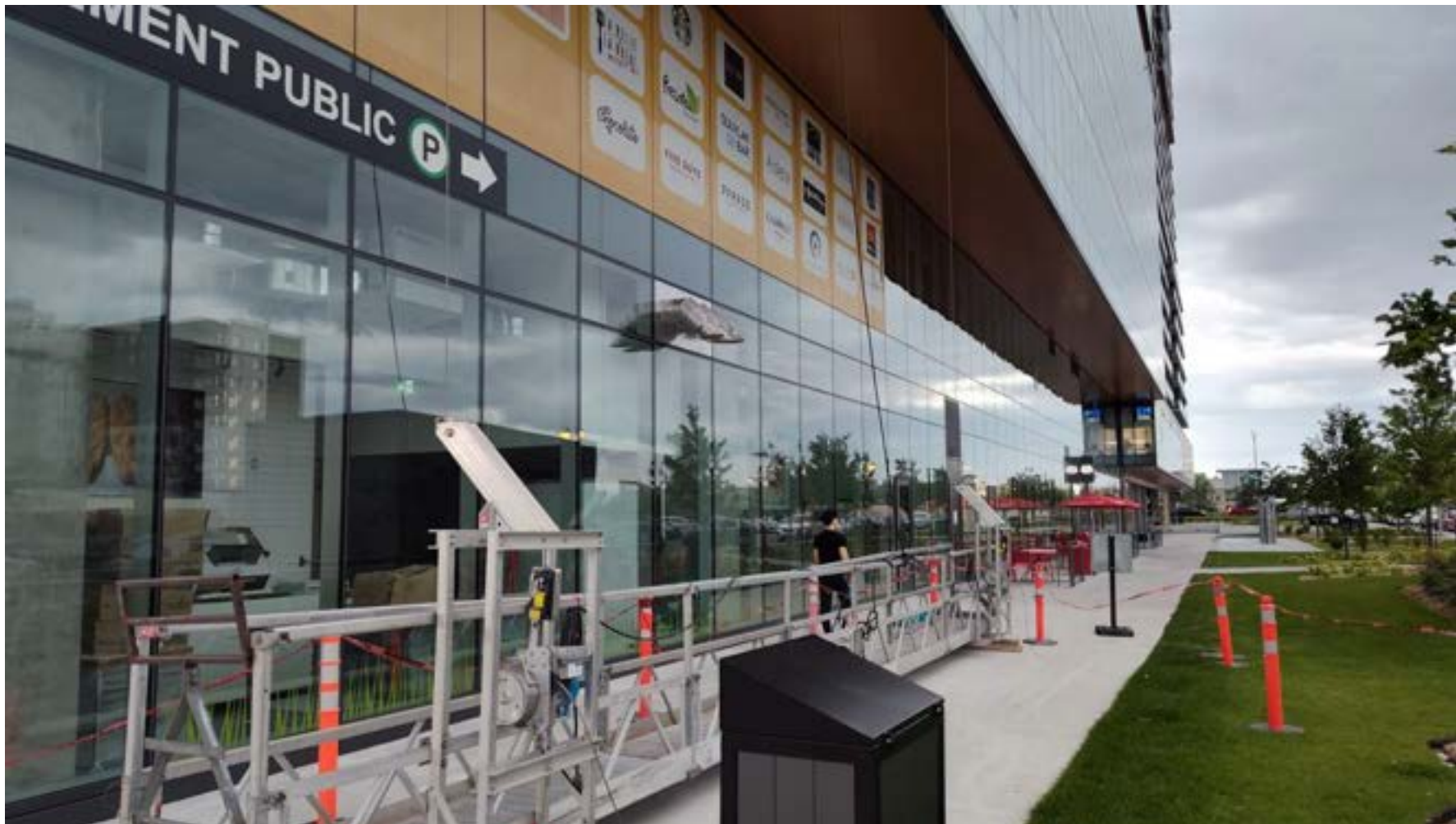
Vue sur le site (tour 2 – façade nord) – Photo prise en date du 20 juillet 2024
