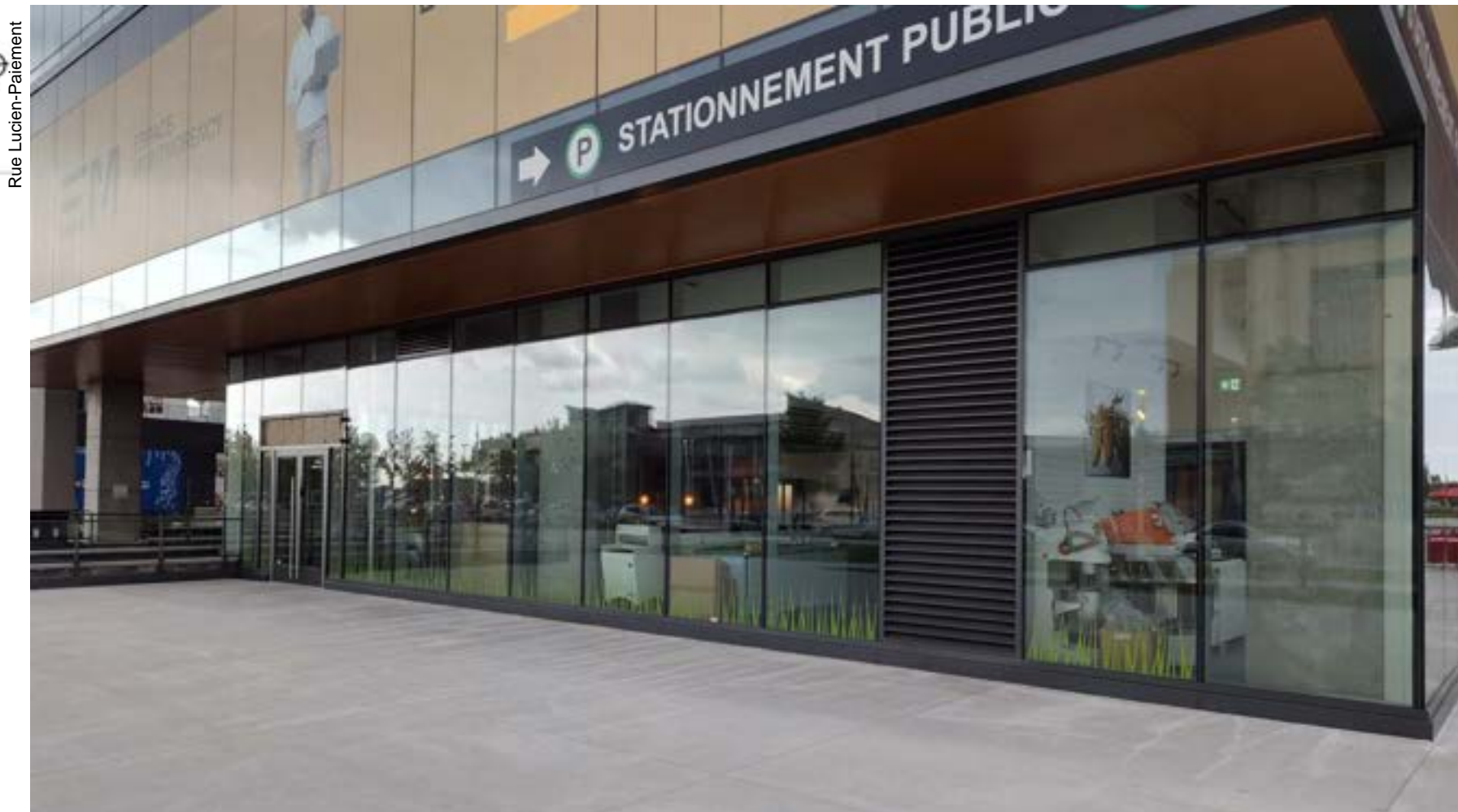
Vue sur le site (tour 2 – façade est) – Photo prise en date du 20 juillet 2024
