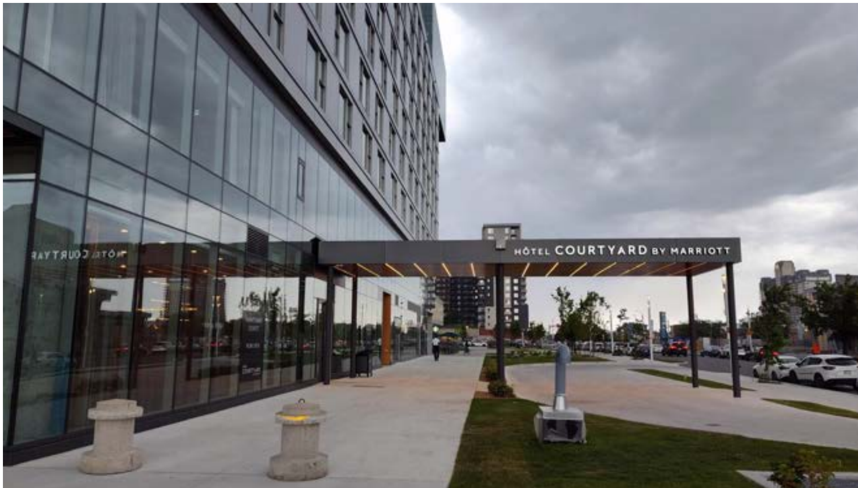
Vue sur le site (tour 3 – façade est) – Photo prise en date du 20 juillet 2024
