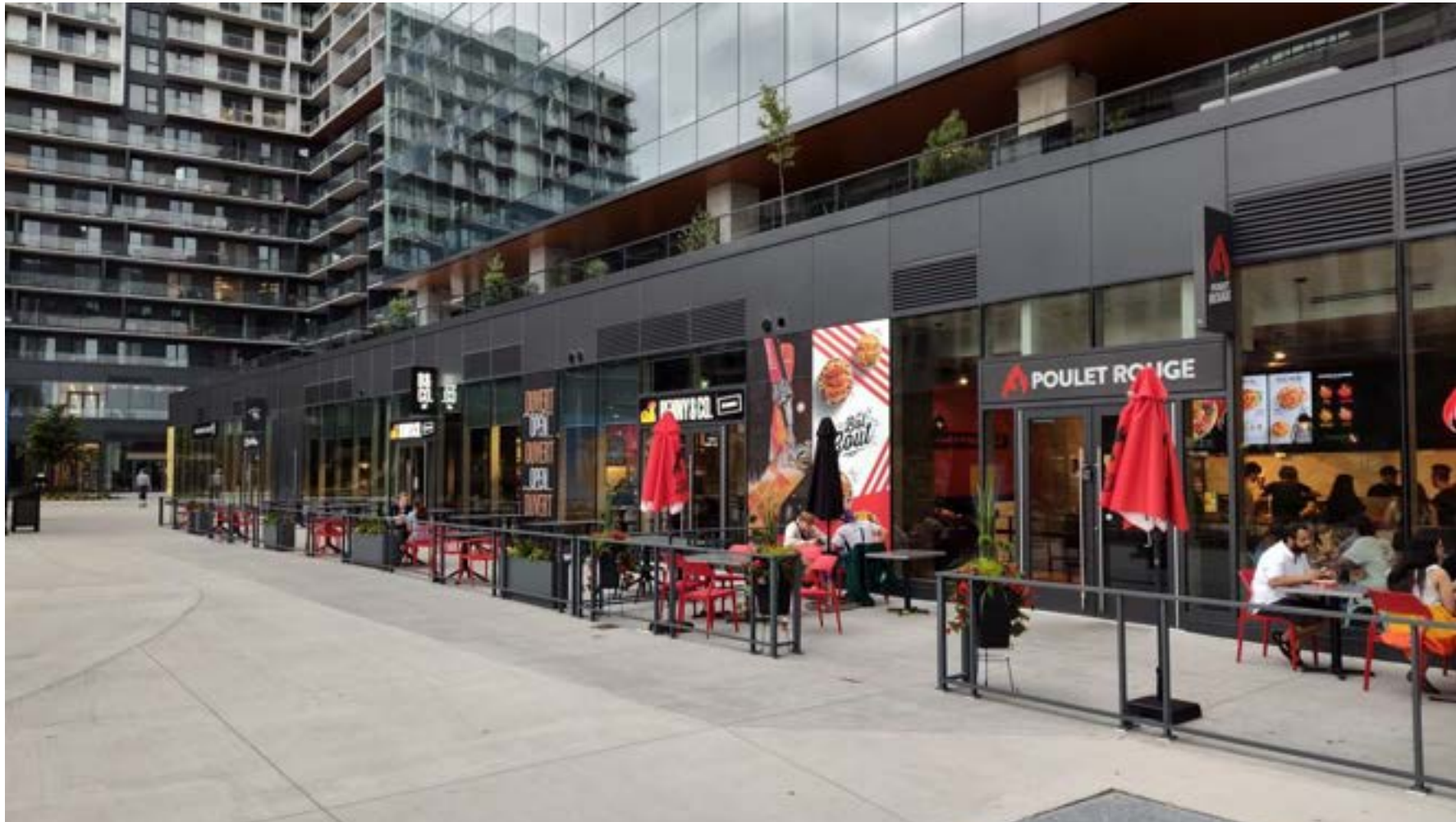
Vue sur le site (tour 2 – façade sud) – Photo prise en date du 20 juillet 2024
