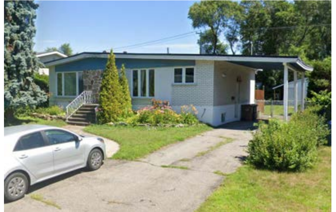
1727, rue Boisvert – Partie sud
