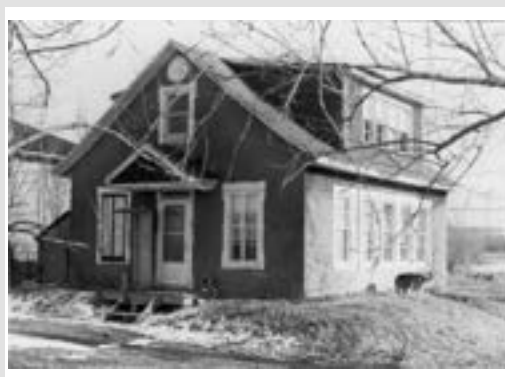
École avenue Perron, 1981
