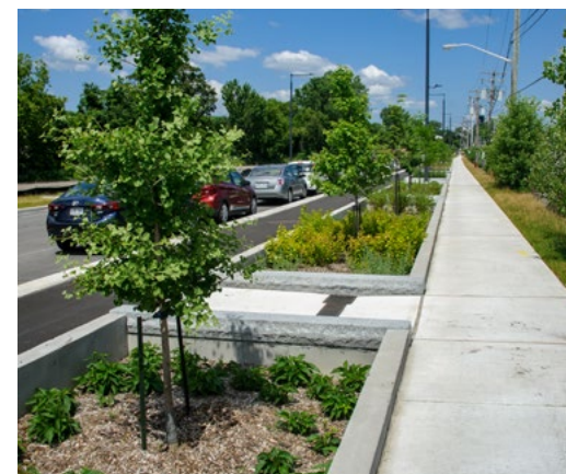
4 Intégration d'un lien cyclable, de plantations et de mesures de biorétention - Avenue Léo-Lacombe, Laval
