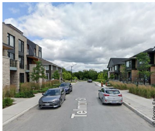
3 Diversité des typologies et marge à l'échelle de la rue - Rue Telmont, Ottawa
