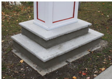
Socle de la croix Vanier (4). Autrefois en bois, cet emmarchement a été récemment refait en béton.
