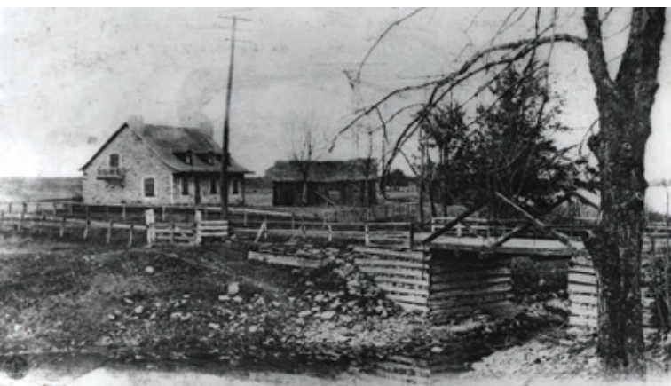
La maison Labelle, un des derniers vestiges du berceau de Saint-Vincent-de-Paul.
