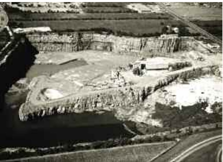
La carrière Lagacé, à Saint-Martin (Chomedey), en 1975 Archives de la Ville de Laval.
