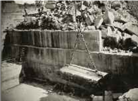
Bloc de calcaire soulevé par une grue
