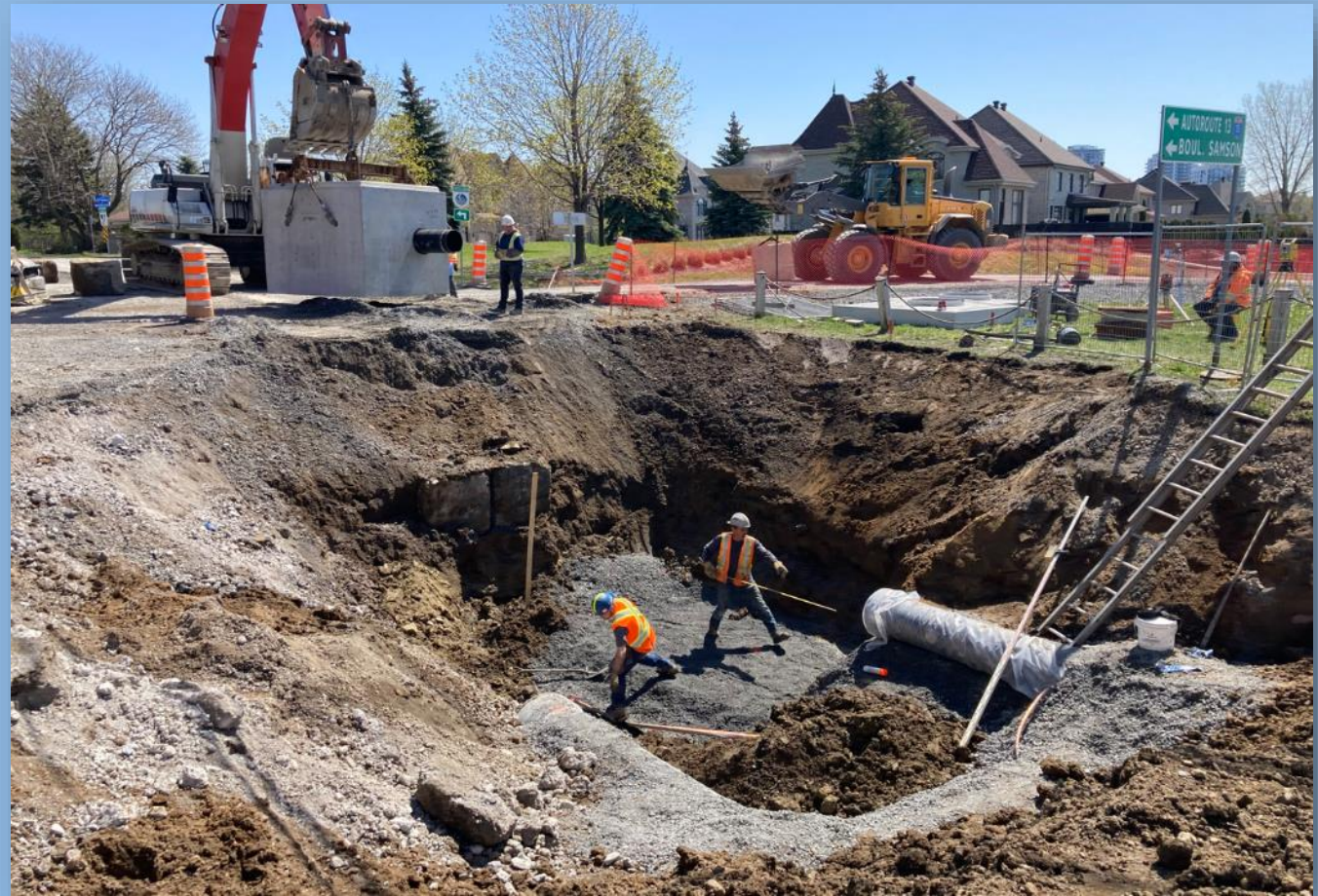
Chantier sur le chemin du Bord-de-l'Eau
